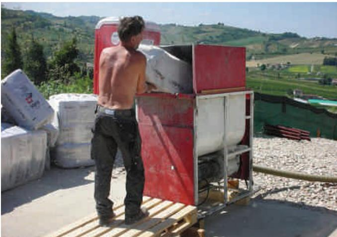
Coibentazione con insufflaggio di cellulosa
