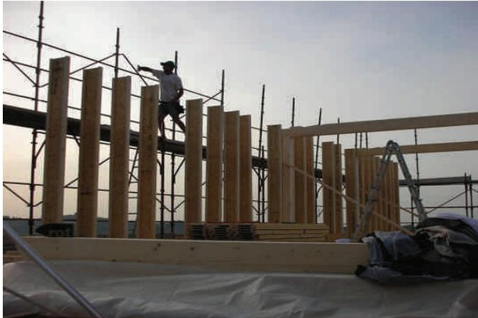
Fase di assemblamento profilati FIJ portanti
