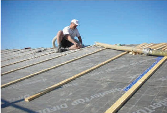
Coibentazione con insufflaggio di cellulosa
