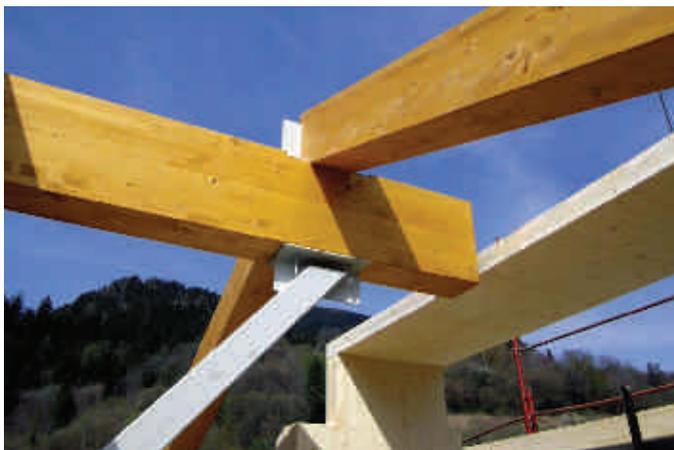
Sistema strutturale sbalzo di copertura
