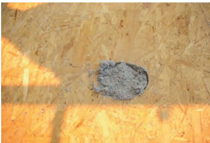
Coibentazione con insufflaggio di cellulosa
