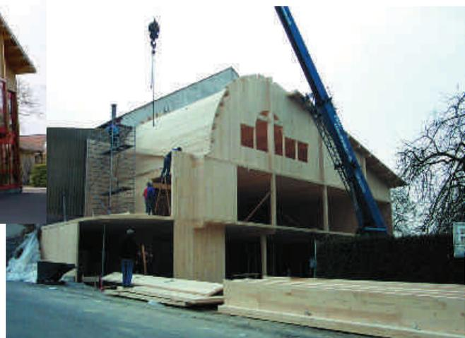
Tipologie costruttive in uso – Sistemi costruttivi ibridi telaio-piastra
