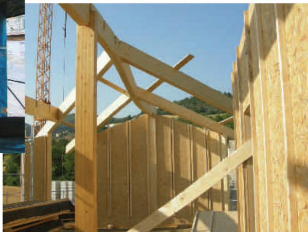
Tipologie costruttive in uso – *Strutture intelaiate vs Sistemi a pareti piene*
