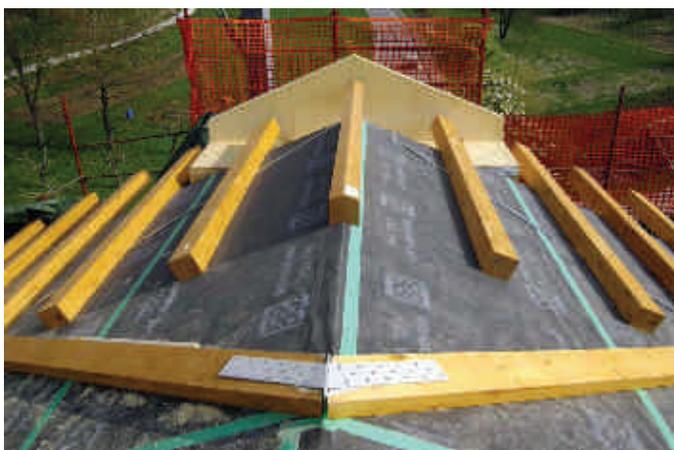
Sistema strutturale sbalzo di copertura
