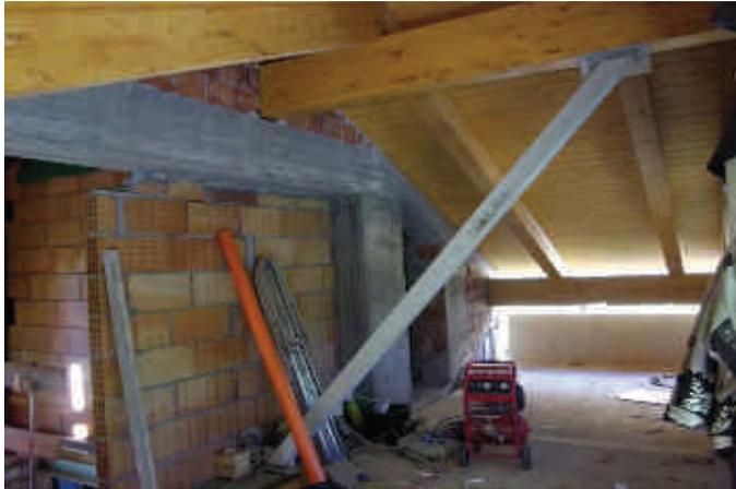
Sistema strutturale sbalzo di copertura
