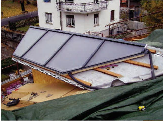
Collettore solare realizzato su misura
