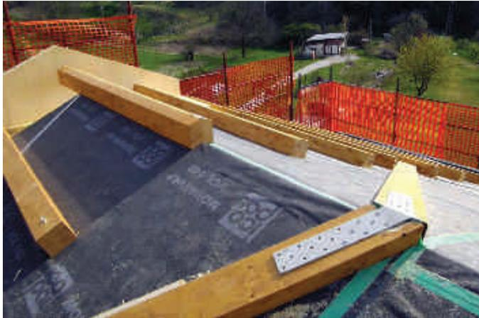
Sistema strutturale sbalzo di copertura
