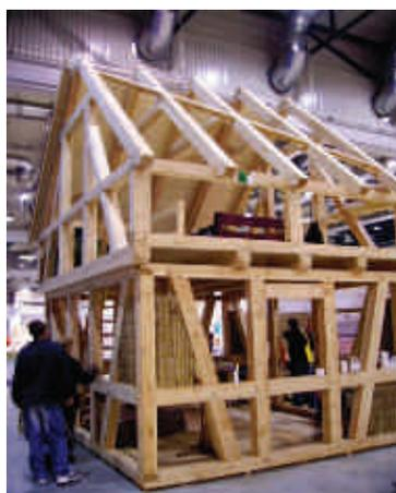
Tipologie costruttive in uso – *Strutture intelaiate vs Sistemi a pareti piene*
