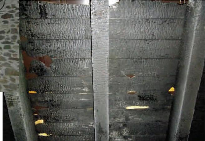
Copertura in legno isolata con pannelli di fibre di cocco – Camino a diretto contatto in acciaio a doppia parete con isolamento 20 mm
